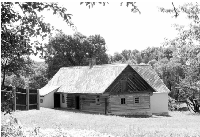
Obděnice čp. 4, stav před zpřístupněním objektu (foto A. Švec)
