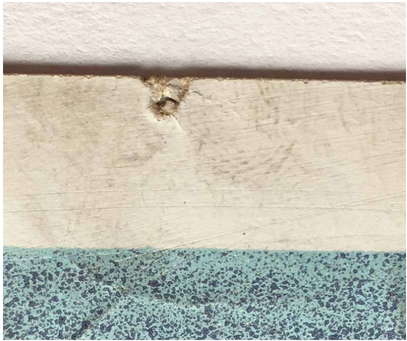
Stopy otěru změkklé minerální hmoty s nečistotami
