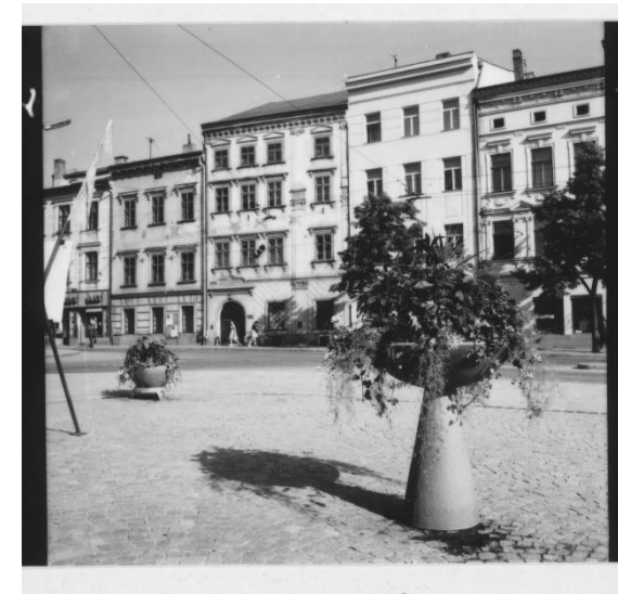
Nové budovy muzea po rekonstrukci
